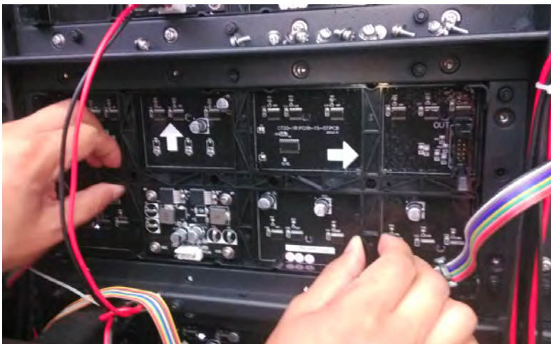
Figur 18: Sette modulen på plass
