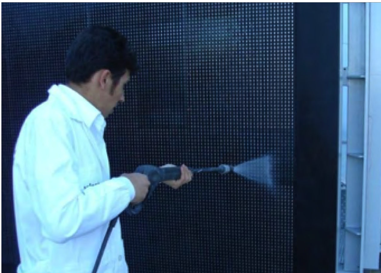
Figur 2: Rengjøring av front-enhetsplaten med vannstråle
